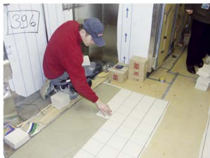
Nicht alle Verlegewerkstoffe auf der „Pride of Hawaii“ sind harzhaltig – unter Deck wurden die Fliesen mit „PCI-Nanolight“ auf zementären Estrichen verlegt.
