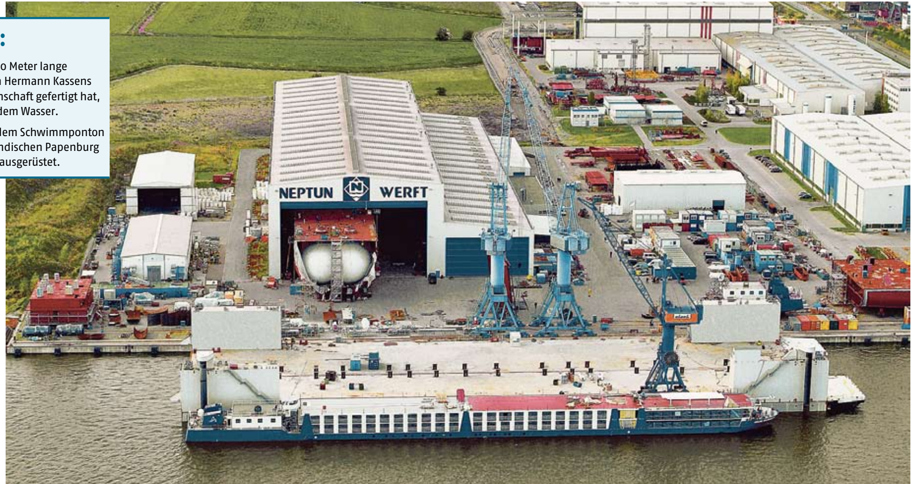
Mehr Platz für den Schiffbau: Das schwimmfähige Beton-Ponton ist inzwischen bei der Neptun-Werft im Einsatz.
