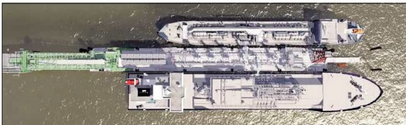
Die schwimmenden Beton-Pontons sind laut Kassens durch eine Gelenkbrücke (links) unabhängig von der Tide, hochseetauglich und beidseitig anfahrbar. Visualisierung: Bauunternehmen Kassens
